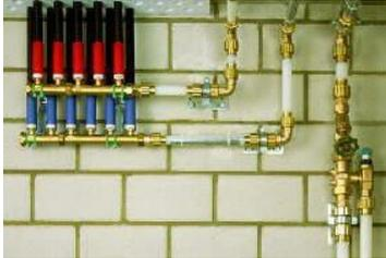
Hauswasserzuleitung mit Absperrhahn und Verteiler zu den Häusern. Kellerverteilungen in gepressten Edelstahlrohren, Warmwasserleitungen, sichtbare Leitungen in Edelstahlrohre gepresst, alles sauber isoliert. Ab Verteiler der Wohnungen Warm und Kaltwasserleitungen in Sanipexsystem oder ähnlichem Produkt (Rohr in Rohr System). Geschlossene Räume werden über Dach entlüftet zB. Luminor Entlüftung.
