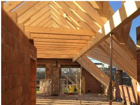
Dachform Mansardendach nach Vorschrift. Holzgebälk bestehend aus Sparren , Zangen, Schwellen aus Tannenholz farblos imprägniert. Mittelpfetten und Firstpfetten aus Brettschichtholz. Unterdach bestehend aus Saglan Dämmplatten Isolation unter den Dachlatten 36mm stark. Isolation zwischen den Sparren, bestehend aus einer Lage Mineralisolation 24 cm. Konterlattung mit 4 cm und Querisolation unter den Sparren. Total Isolationsstärke von 28 cm. Dampfbremse Ampatex DB90 von
