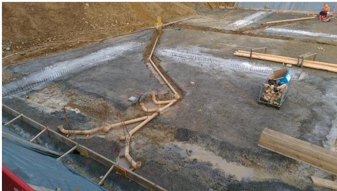
Kanalisation gemäss den Bauvorschriften. Anschluss an bestehende Kanalisation auf dem Nachbargrundstück mit Anschluss an die Gemeindekanalisation. Alle Leitungen in PVC Rohre im Trennsystem. Alle nötigen Schächte und Sammler nach Vorschrift der Behörde. Unter der Tiefgarage entsteht ein Sickerschacht. Zusätzliche Rinne vor Garagentor, bei eventuellem Platzregen.
